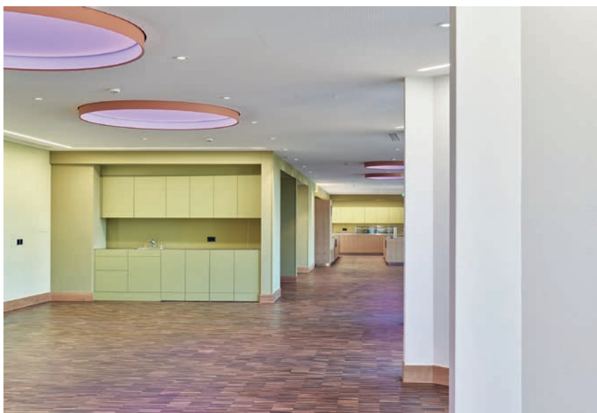
Stimmung: Lichtdecken mit RGB LED ermöglichen das Einstellen einer beliebigen Lichtfarbe
